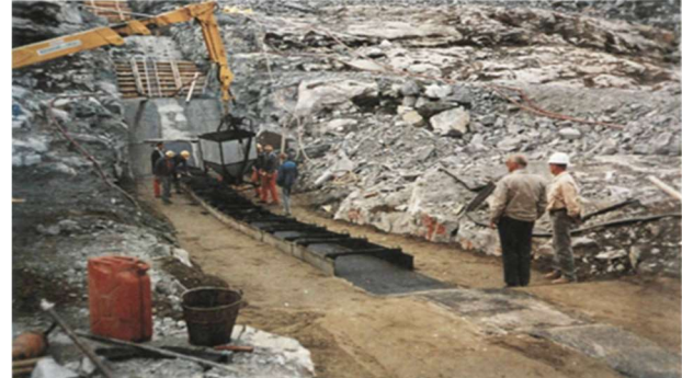
Colocación de primeras capas de concreto asfáltico. con proceso manual
