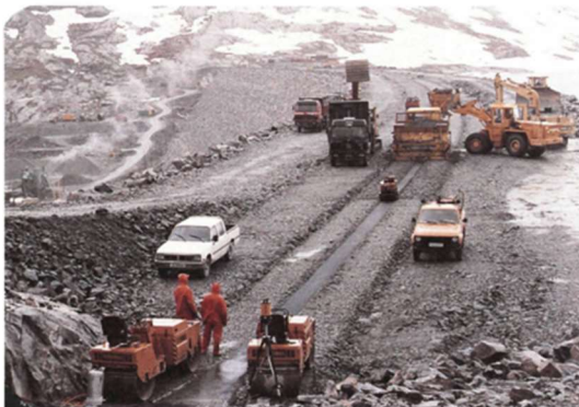
Figura 17. Acciones de finalización de terraplén y núcleos asfálticos en la represas de Styggevatn y Riskallvatn en Noruega. Véase que los equipos constructivos son comunes en Honduras
