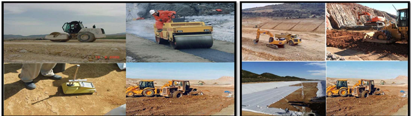
Figura 18 Actividades de Terracería en el cuerpo de la presa. Equipos comunes en Honduras.
