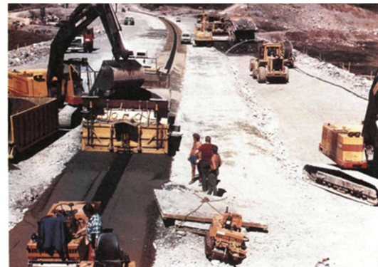
Figura 17. Acciones de finalización de terraplén y núcleos asfálticos en la represas de Styggevatn y Riskallvatn en Noruega. Véase que los equipos constructivos son comunes en Honduras
