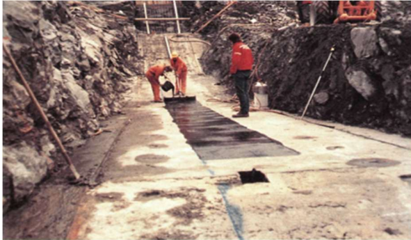
Imprimación de fondo de Cimentación con asfalto para el desarrollo del núcleo
